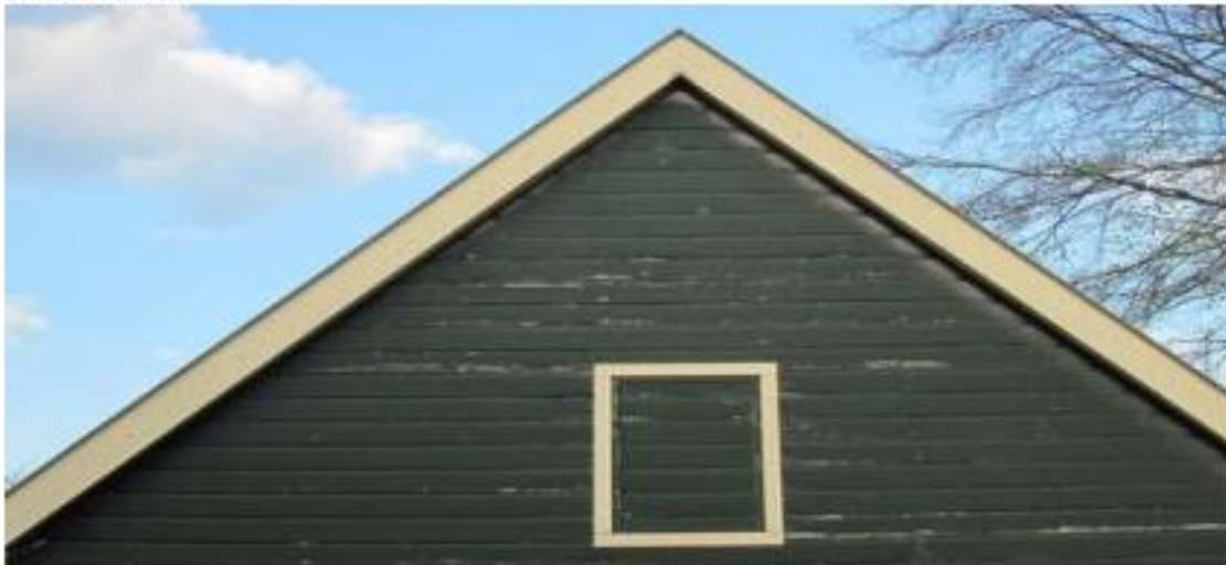
Achterzijde garage, geen zwaluw nestvorming
