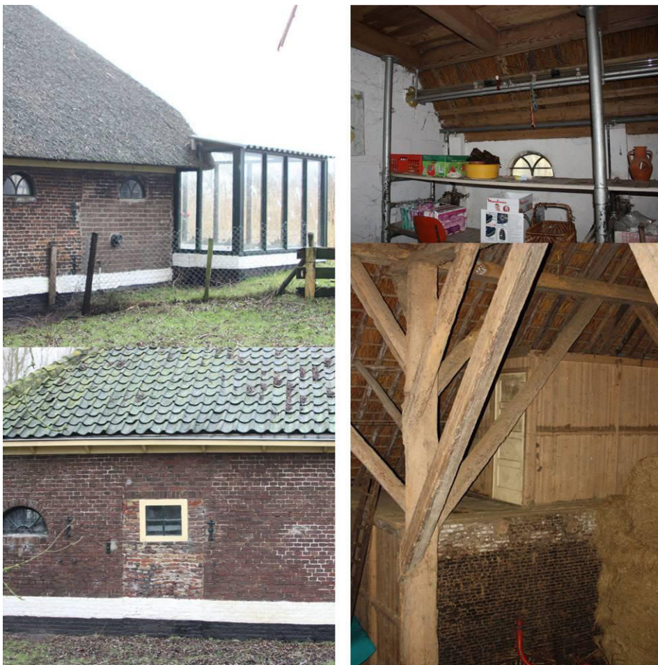
Afb 4.2: links: bouw-en shadesporen
