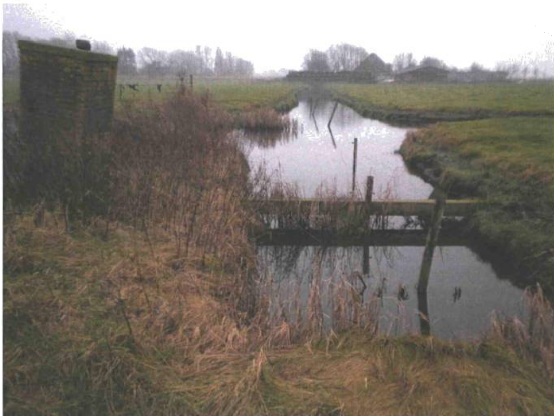
Figuur 2. De locatie waar de dam met duiker wordt vervangen, gezien in zuidelijke richting. De foto is genomen vanaf de te verwijderen dam. De nieuwe dam wordt ca. 8 m zuidelijk van de huidige aangelegd, dus vlak achter de betonnen balk over de sloot. .
