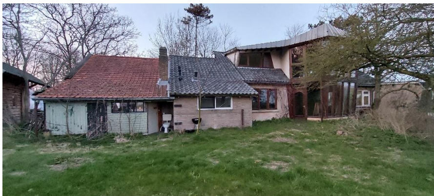
Figuur 3: Zuidaanzicht (achterzijde)
