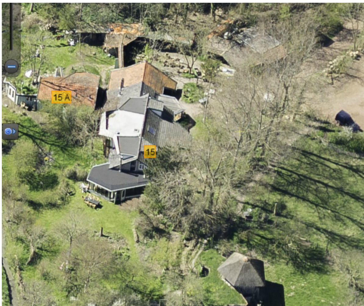
situatie met de aanbouwen; het grootste deel is inmiddels gesloopt
