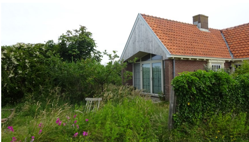
Foto 2: Foto West-zuidgevel van het "speelhuis", uitbreiding "B".
