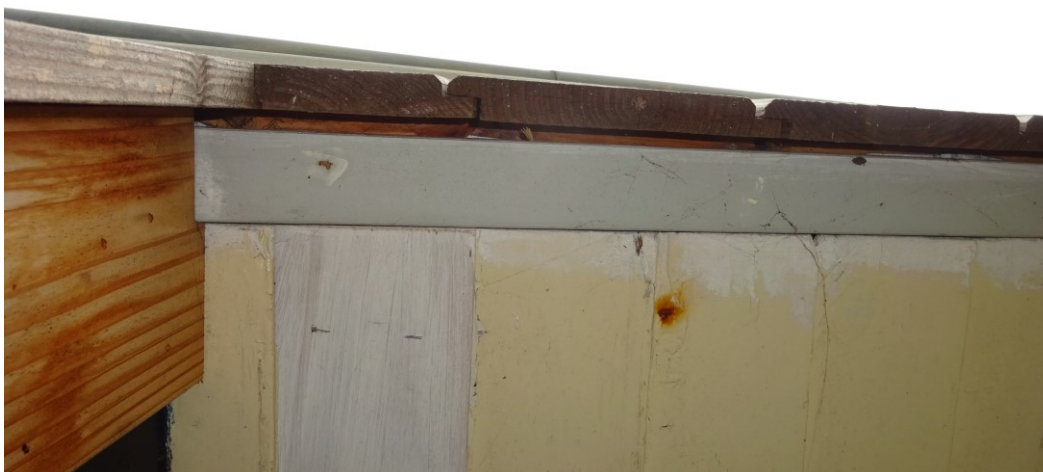
Foto 4: Gesloten westelijke kopgevel- en plafondbetimmering "Speelhuis".
