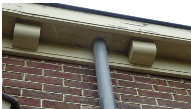
foto 21: gesloten aansluiting smetplank-metselwerk en hwa-doorvoer
