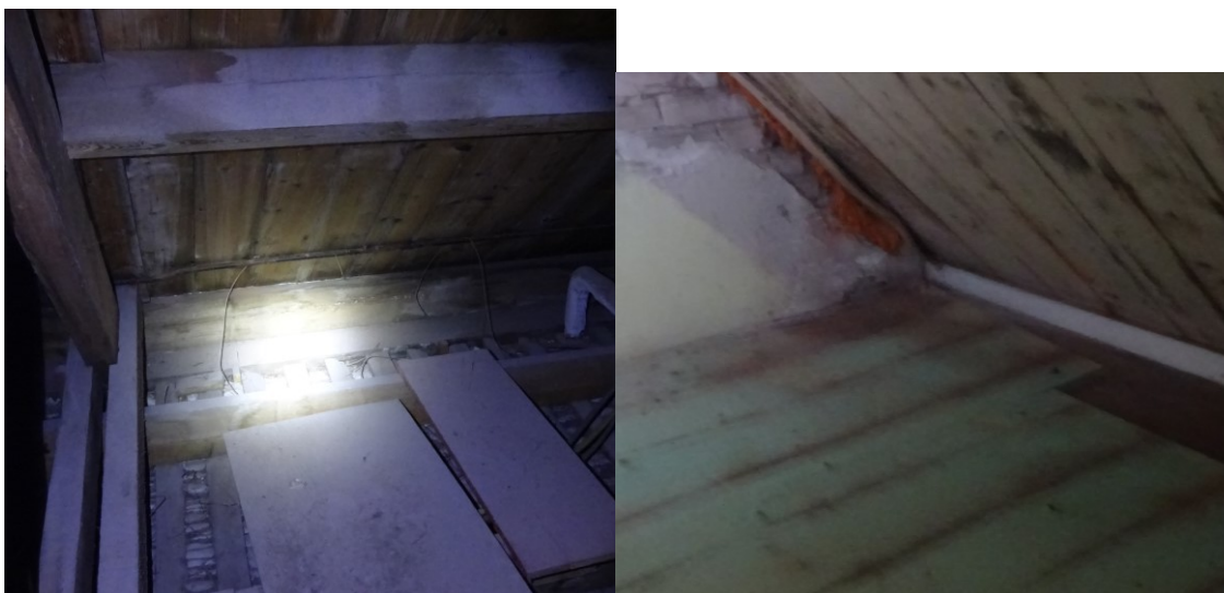
foto 8 en 9: gesloten aansluitingen van dakbeschot met muurplaat
