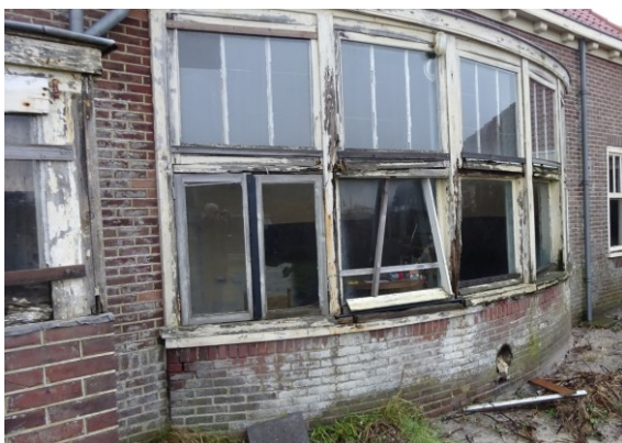
foto 12: boogkozijn koloniehuis westgevel
