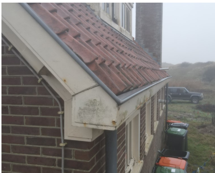
foto 7: Pannen- en waterlijn i.r.l.t. dakgoot
