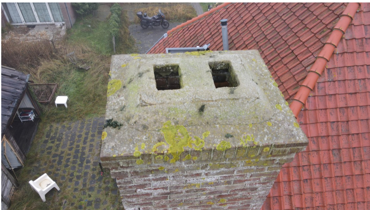
foto 16: Twee rookkanalen in de te slopen schoorsteen.
