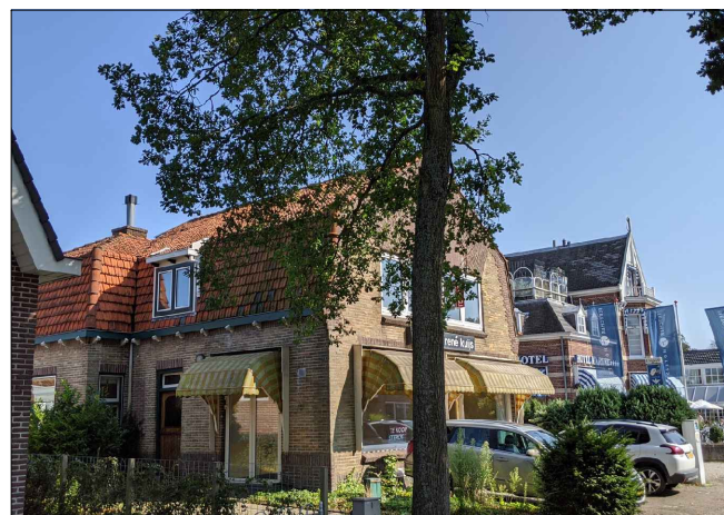
bestaande voorgevel/linker zijgevel
