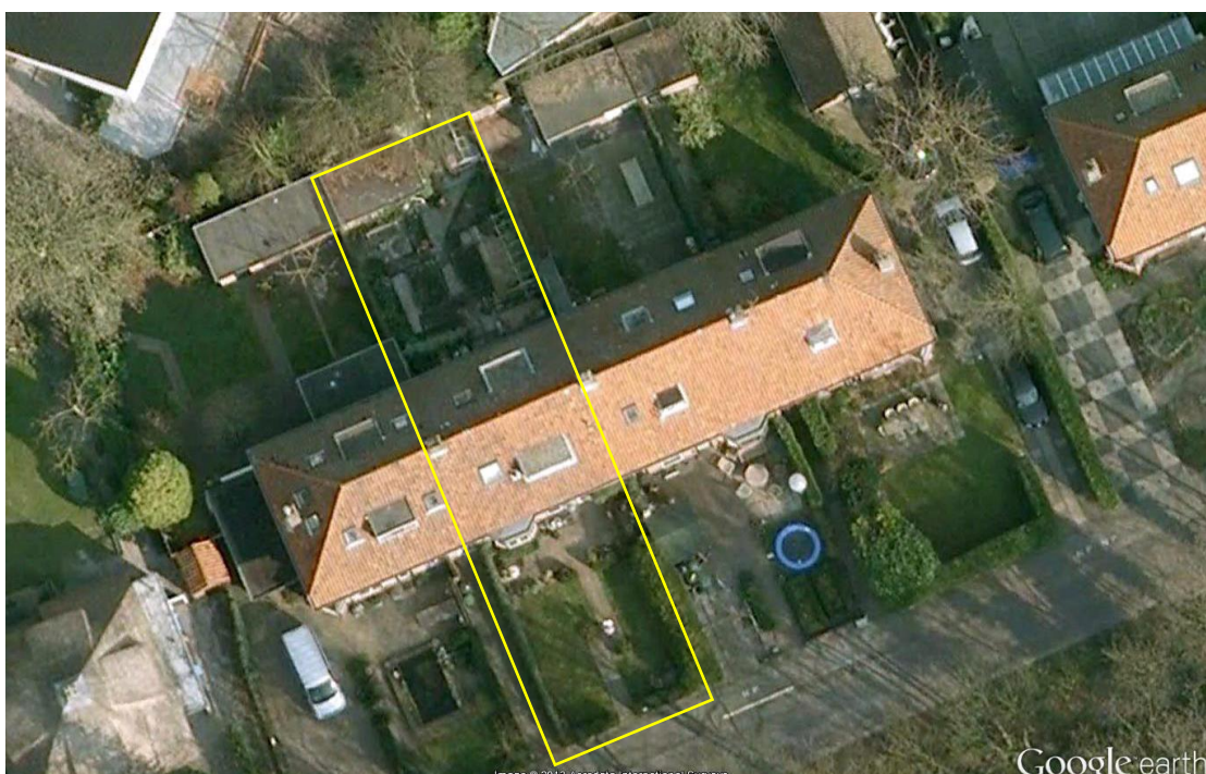
afb. 2 De bestaande situatie Berkenlaan 16
