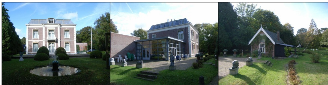
Figuur 2 Voorzijde villa, aanbouw achterzijde en bijgebouw
