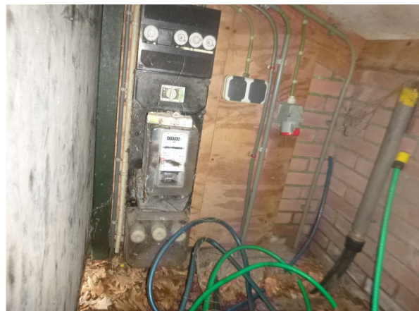
Inspectie meter hokje 1
