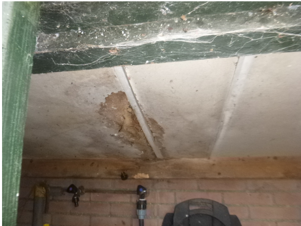
Inspectie plafond hokje 1
