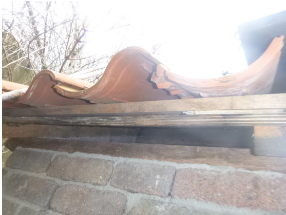
Inspectie dak hokje 2
