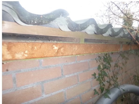
Inspectie dak hokje 1
