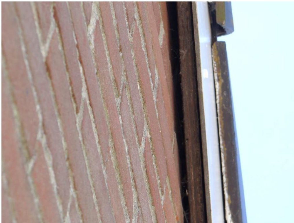
Foto 2. Achter boeidelen, die langs de dakrand van beide kopensijden van het gebouw aanwezig zijn, is voldoende ruimte aanwezig voor vleermuizen om er verblijfplaatsen te kunnen hebben.
