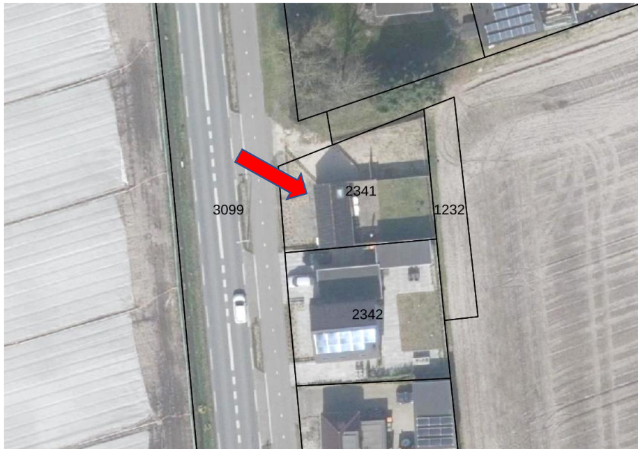
Figuur 2. Luchtfoto waarop de recreatiewoning met een rode pijl wordt aangeven. Op de foto worden ook de kadastrale percelen aangegeven (planperceel: nr. 2341).
