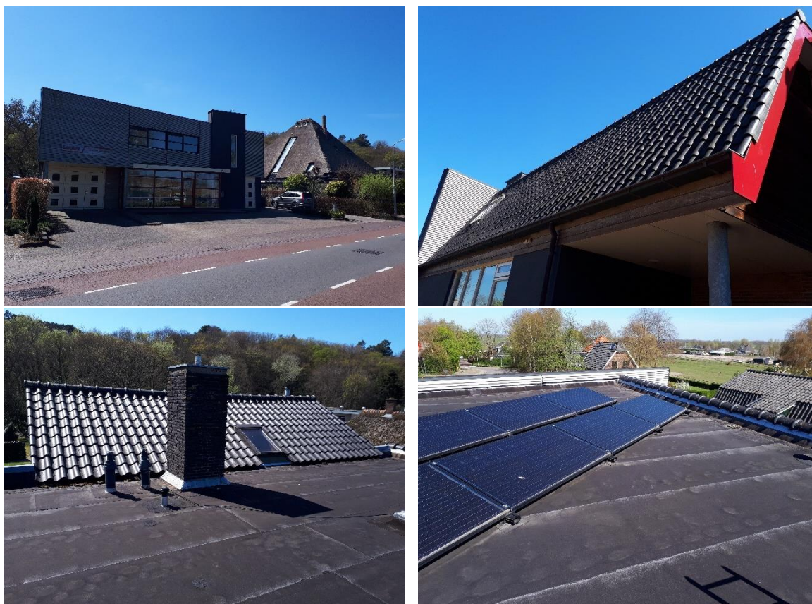
Figuur 2.1 Enkele foto's van (het dak van) de planlocatie.
