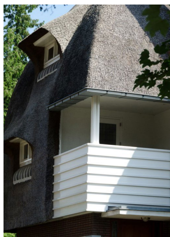
Bijzondere dakvorm met loggia
