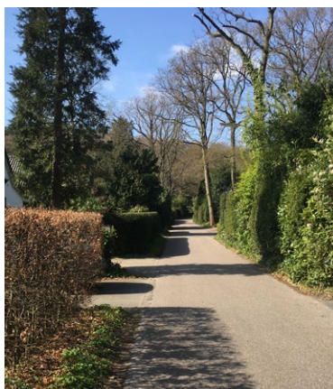
rijpaden met afgestrooid asfalt, k&l in de berm
