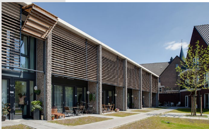
Moderne architectuur met hout en baksteen
