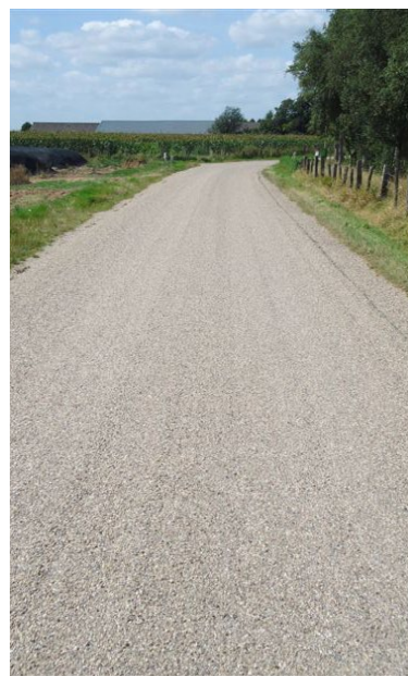
Asfalt met grind in de toplag (afstrooien bij het walsen)
