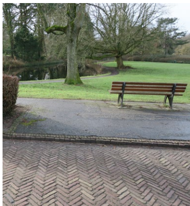
Klinker rijbaan en asfalt stoep met rollaag opgesloten k&l in naastgelegen groen
