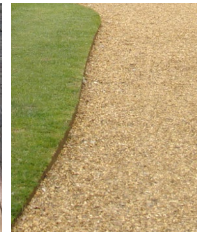
Referentie, oprit van halfverharding
