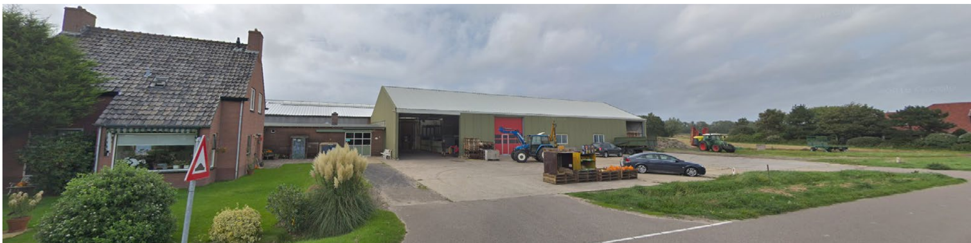
Bedrijfswoning met daarnaast de schuur, schuurkas erachter gelegen. Erfverharding op voorgrond. (foto van Google Streetview 2019)
