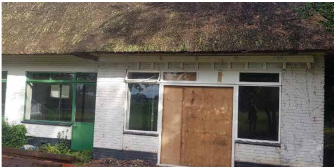
De villa ter plaatse van de uitbouw.
