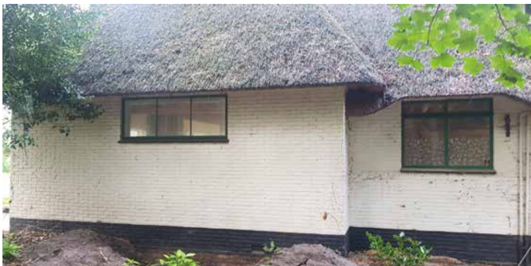
De villa ter plaatse van de uitbouw.
