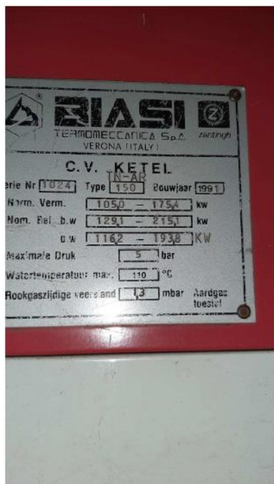
Figuur 1: kenplaatjes van de bestaande ketels.
