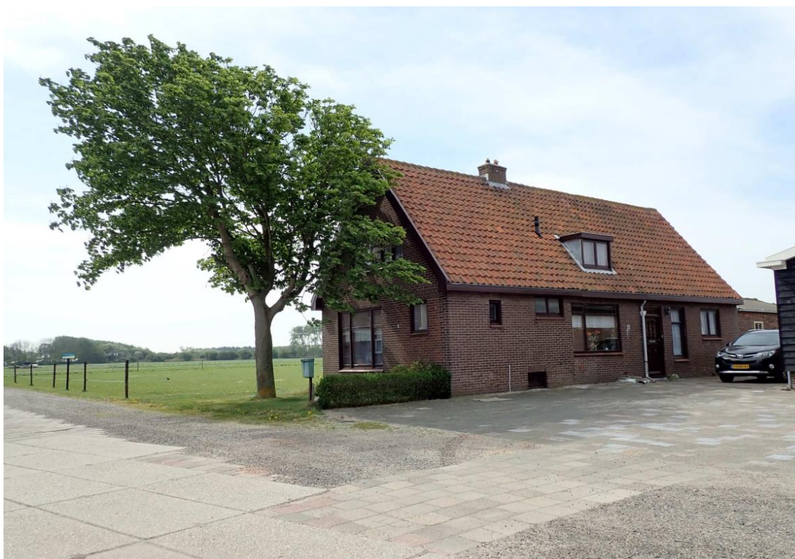
afbeelding 5: aanzicht van het terrein (bron: Ecologisch onderzoek Van der Goes en Groot, d.d. 3-5-2019)
