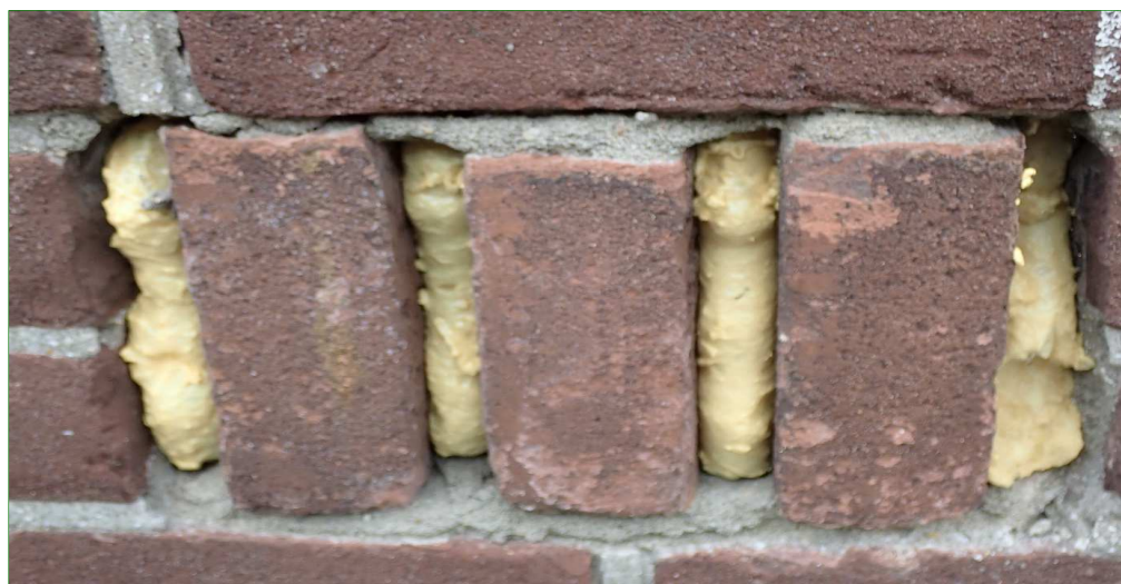
Met behulp van purschuim afgesloten stootvoegen.
