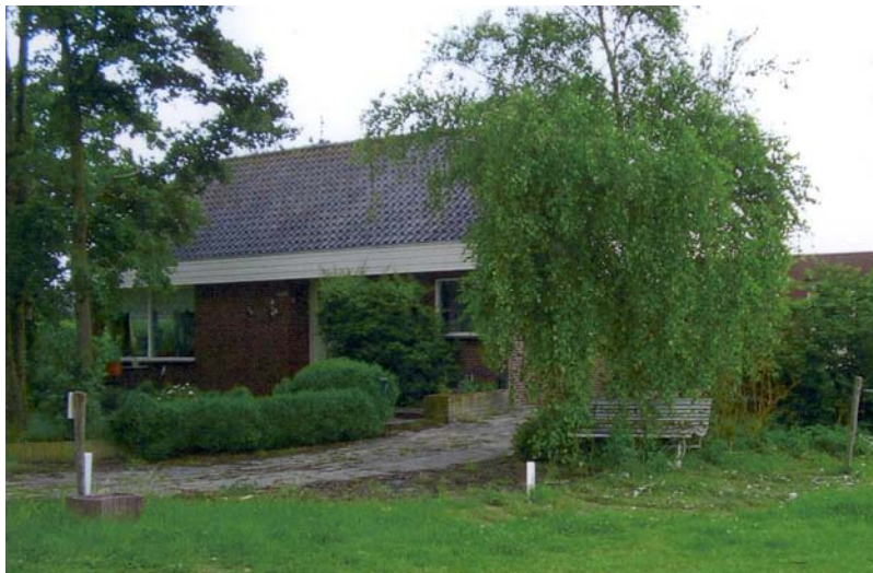
Voorzijde van de woning
