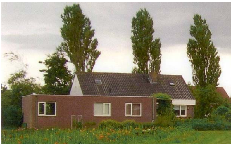
Achterzijde van de woning met aanbouw uit 1993
