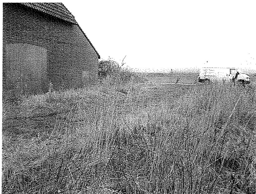
Foto 29 Deelgebied 2, puinverharding onder gras rondom gebouw, richting west
