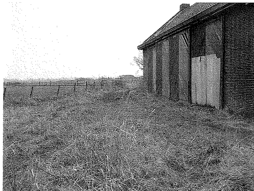
Foto 30 Deelgebied 2, puinverharding rondom gebouw, richting zuid
