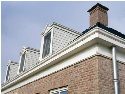
dakkapellen toegestaan, verticaal geled en los van de gootlijst in het dakvlak geplaatst
