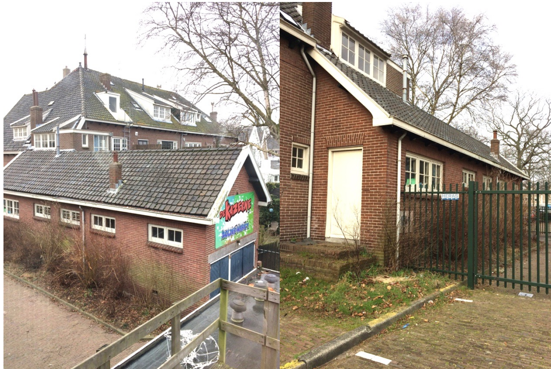
Afbeelding 9 en 10. De aanbouw van het voormalige politiebureau
