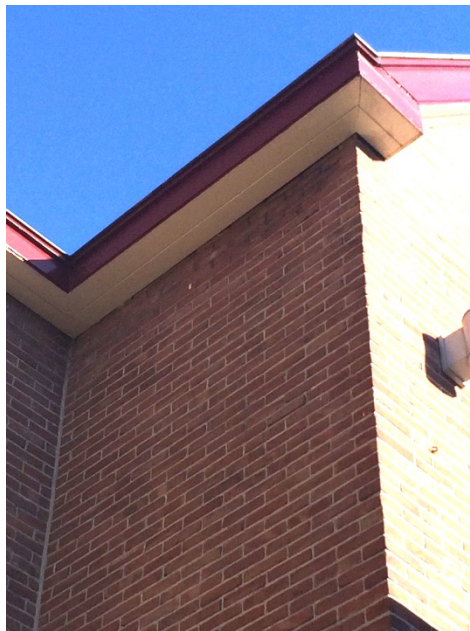
Afbeelding 4. Het hotel vanaf de Stationsstraat, rechts de gevel met kieren in het metselwerk en onder de goot.
