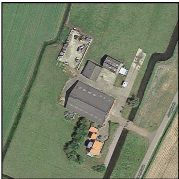
Bestaande situatie Jaagkade 5
