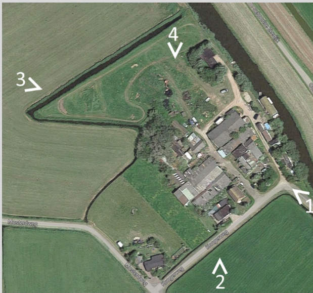
Bestaande situatie, met nummers en richting foto's
