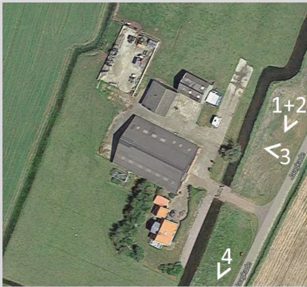
Bestaande situatie, met nummers en richting foto's
