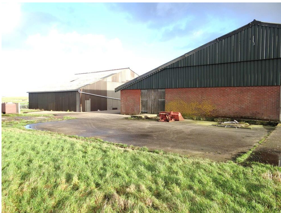
Foto 2 Planlocatie Jaagkade 5. Zicht op twee op het perceel gelegen schuren.
