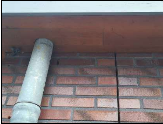
Afbeelding 2: Ruimte in dilatatievoeg en stootvoeg
