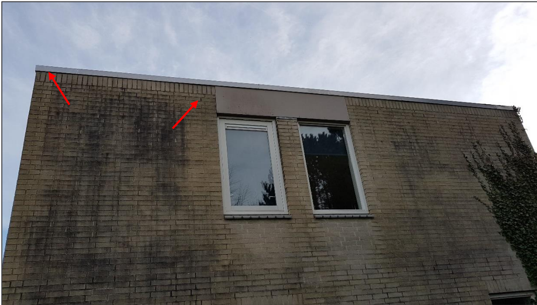
Figuur 14. Open stootvoegen en niet sluitende daktrim, geschikte invliegopeningen voor vleermuizen.
