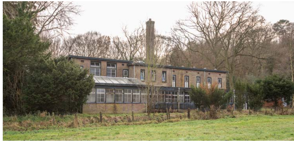
aanzicht op bollenschuur (Duinweg 21) vanaf noordoostzijde voor brand
