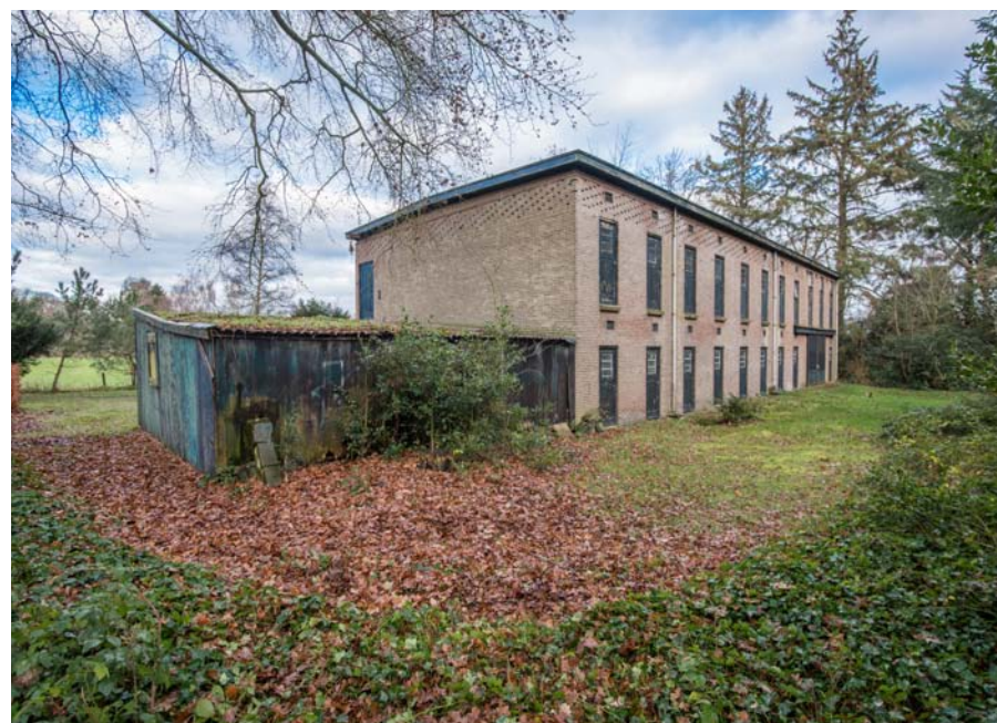
zuidwestzijde bollenschuur voor brand + open plek zuidelijk daarvan
