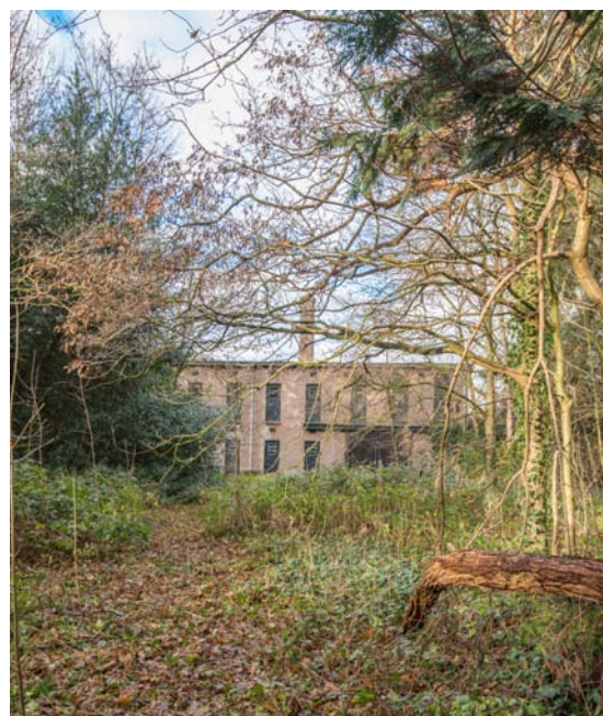
doorzicht op bollenschuur vanaf zuidzijde terrein
