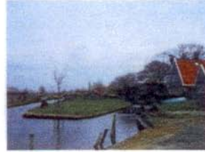
Informele overgang met lage beschoeiingen
