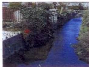
Onwenselijke situatie met kunstmatige overgangen naar het water
