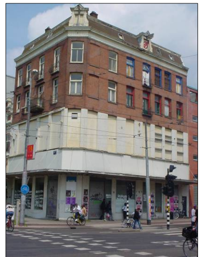
Afbeelding: het monumentale hoekpand Wijtenbachstraat 5-7
