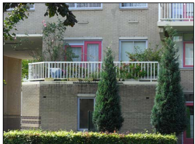
Afbeelding: dakterrassen op uitbouwen
