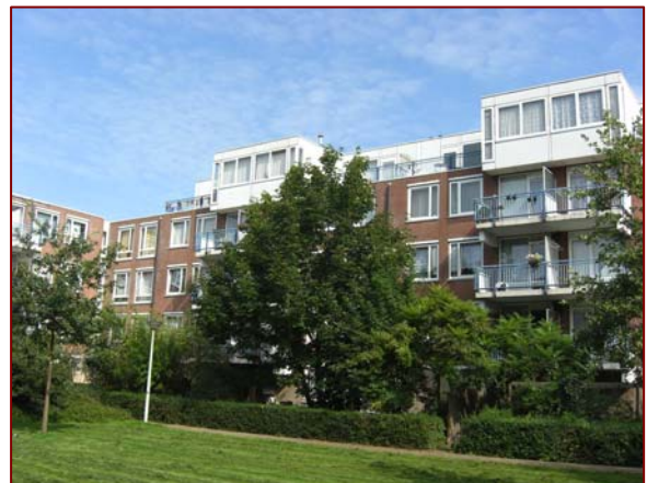
Afbeelding: binnenzijde bouwblok met dakterrassen op de vierde bouwlaag
