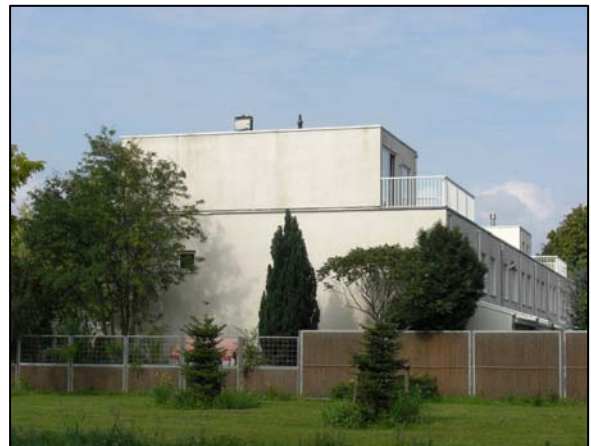
Afbeelding: aan-/uitbouwen aan de achterzijde van de woningen aan de Bretanostraat
