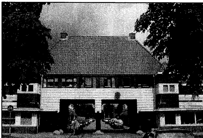
Figuur: Overbouwde doorgang langs de Purmerweg.
