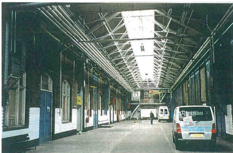
Draagconstructie met polonceauspanten
