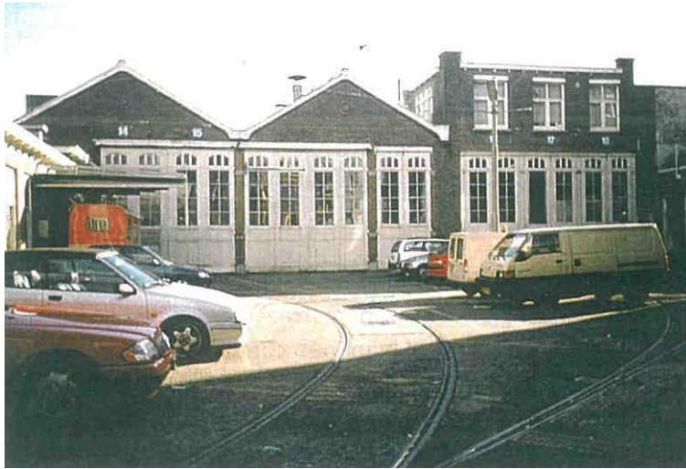
Hallen waarin mogelijk het cultuur- en informatiecentrum opgenomen wordt
