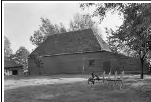
Zijgevel schuur 1976 (bron: Rijksdienst cultureel erfgoed)
