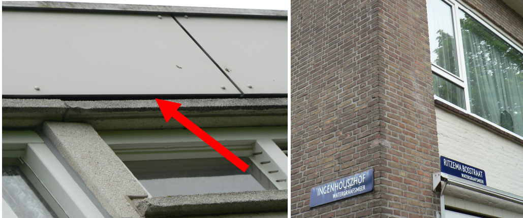
Afbeelding 4. Potentiële verblijfplaatsen voor vleermuizen
