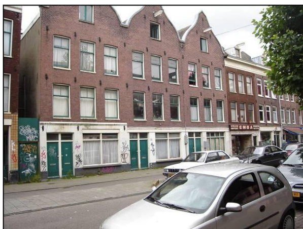
Afbeelding: enkele bestaande panden in project O.21
