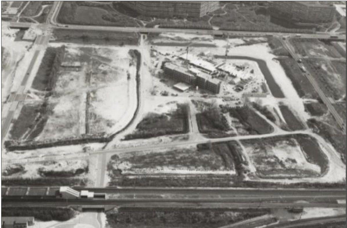
Afbeelding: luchtfoto van het in aanbouw zijnde woonzorgcentrum in 1981, gezien vanuit het westen (bron: beeldbank Amsterdam)
