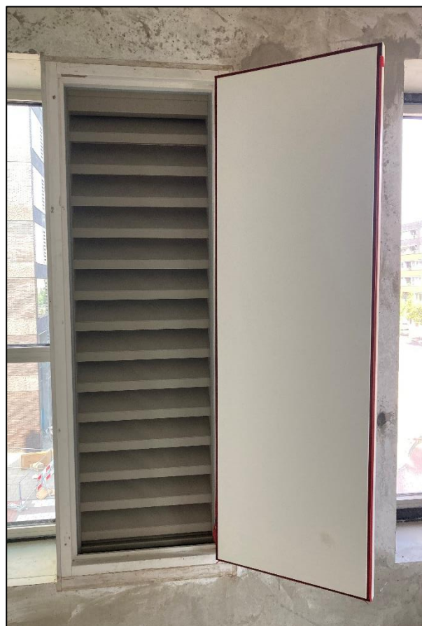
Fig. 8: Foto's van geopende comfort-box bij de Postjesweg 702 te Amsterdam. Bron: Geurst & Schulze
