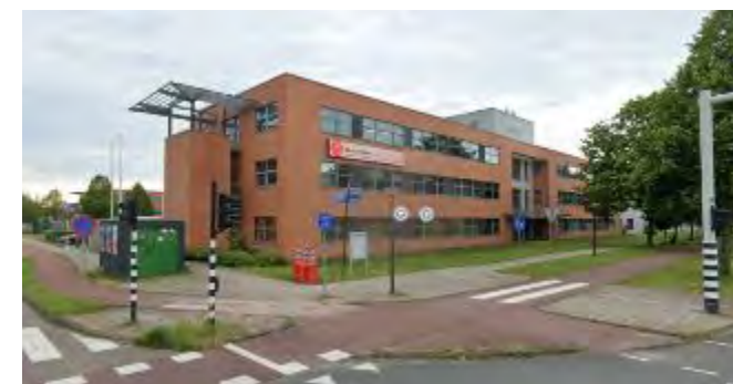
Figuur 7: Aanzicht gebouw vanuit oosten (bron: Google Streetview)
