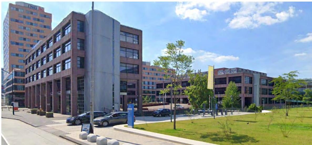
Afbeelding: zicht op de huidige bebouwing en het parkeerterrein vanuit de Bijlmerdreef
