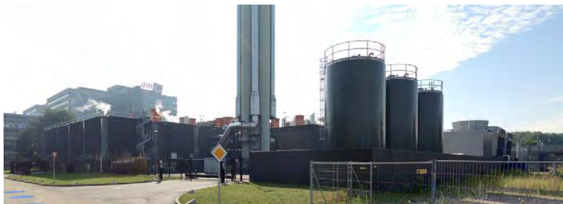
Figuur 4.10 Huidige Energiecentrale, bouwdeel V
