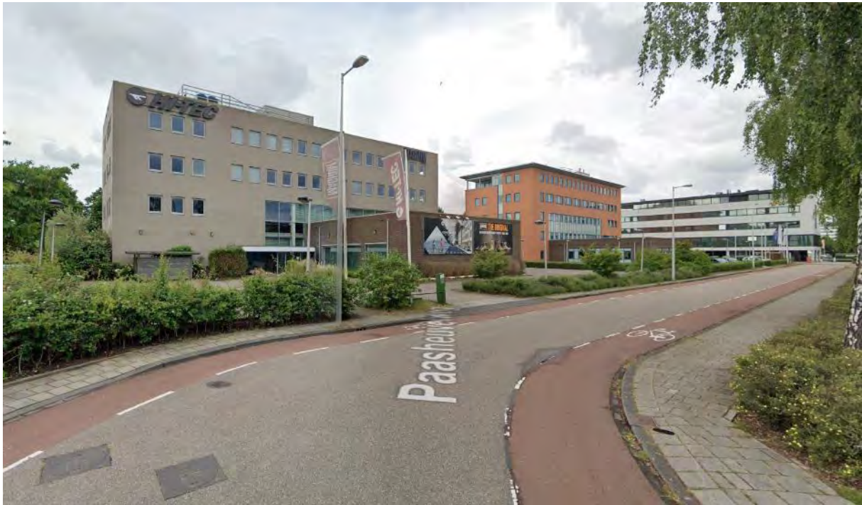
Figuur 2.2: zicht op het projectgebied vanaf de Paasheuvelweg (bron: Google Streetview)
