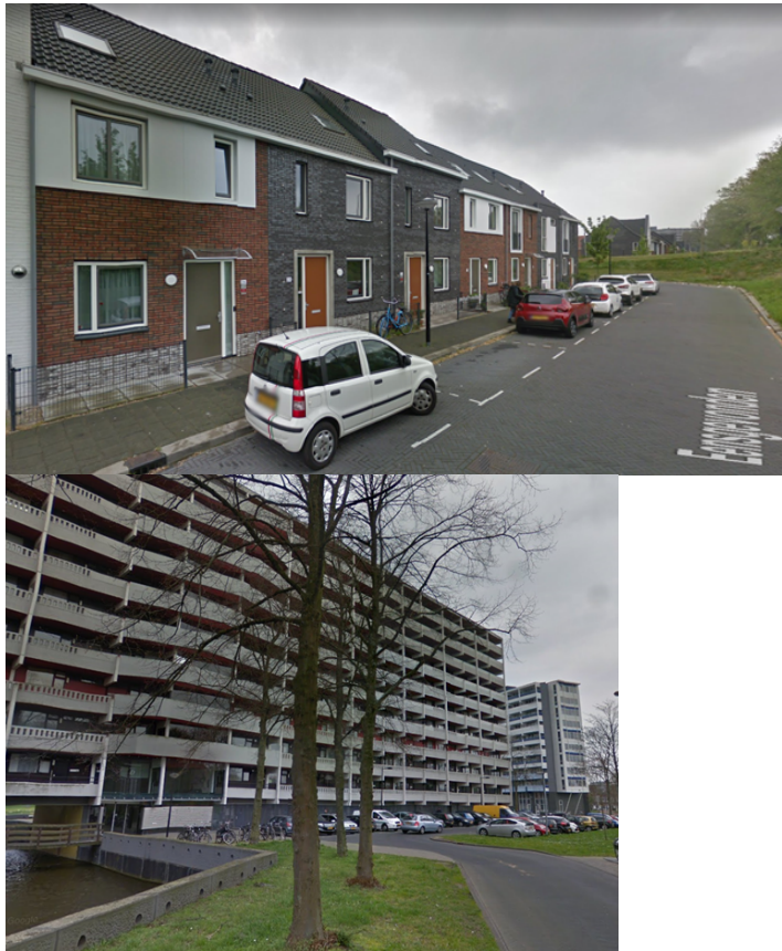
Afbeelding: de aan het plangebied grenzende laagbouw E buurt, Eensgevonden en flats Geldershoofd (links) en Gravestein (rechts)(bron: Google streetview)
