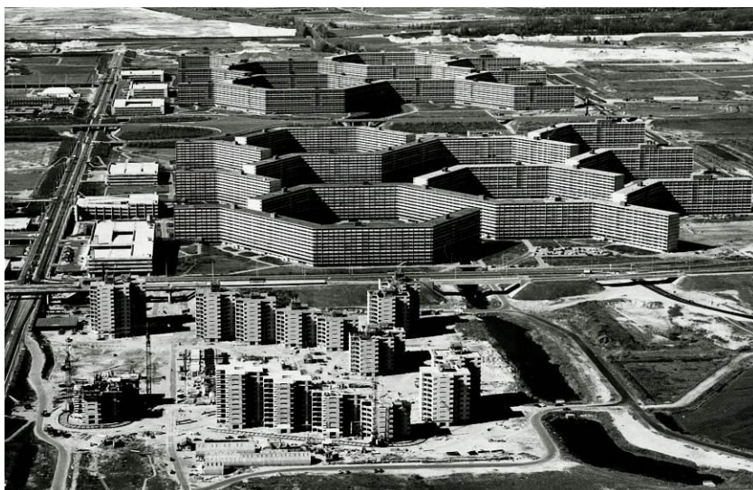
Op de voorgrond Groenhoven en Gouden Leeuw in aanbouw, april 1974; op de achtergrond de delen B en C (SAA B00000034523)
