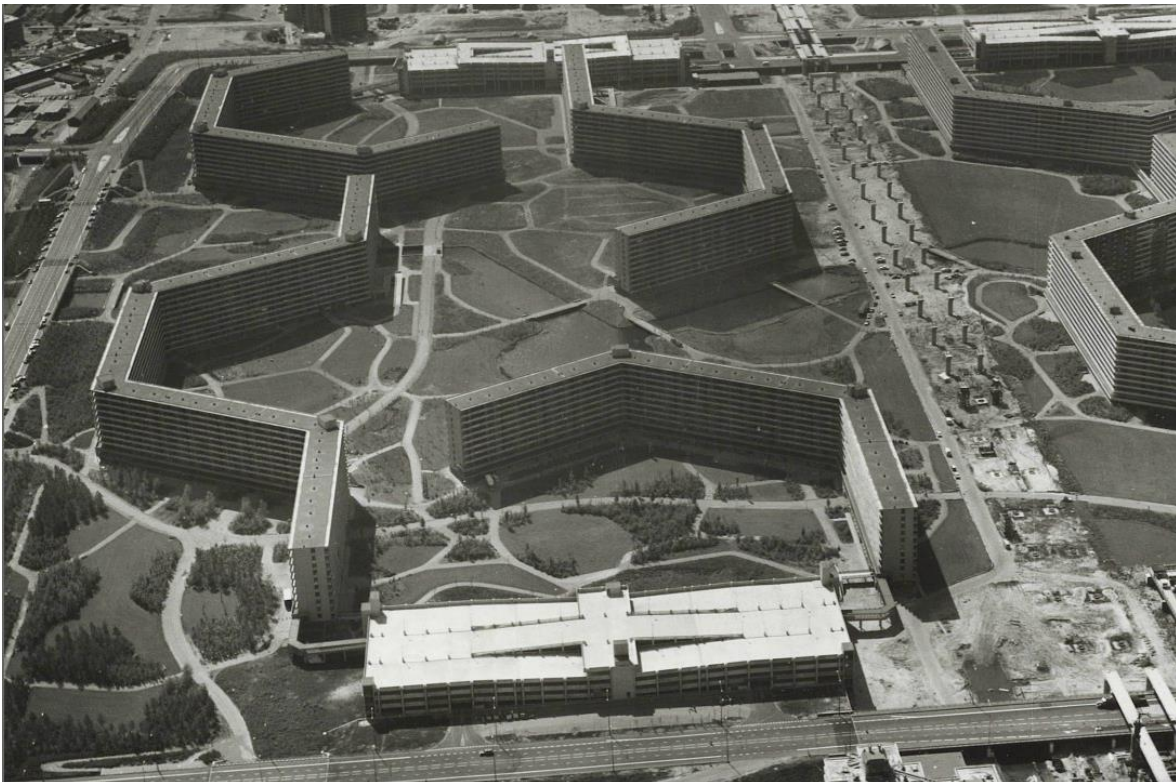
Deel E, ten oosten van de metrobaan in aanbouw; links Grunder en Koningshoef (beide gesloopt), rechts Grubbehoeve en Kleiburg. Langs de Bijlmer- en Karspeldreef de beide dubbele parkeergarages (gesloopt), juni 1973 (SAA B00000034867)
