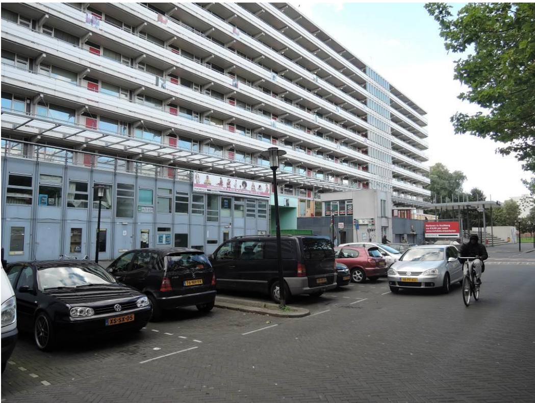
Kruitberg met uitgebouwde plint t.b.v. parkeergarage, ateliers en grondgebonden woningen, oktober 2016
