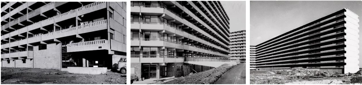
Architectuur, van links naar rechts: deel B en C (Fleerde, SAA 5293FO011669), deel E (Grubbehoeve SAA 5293FO011343) en deel D (Gooioord SAA 5293FO012049)
