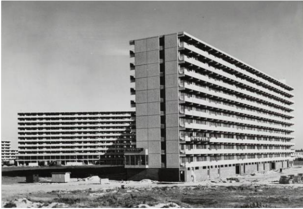
Grubbehoeve rond oplevering, ca. 1970 (SAA 5293FO010884)
