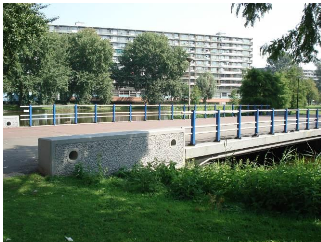
Brug 1146, voetgangers-/fietsbrug bij Gooioord, september 2014
