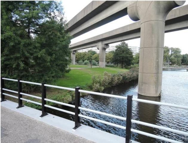
Brug 1613, het dubbele metroviaduct, oktober 2016
