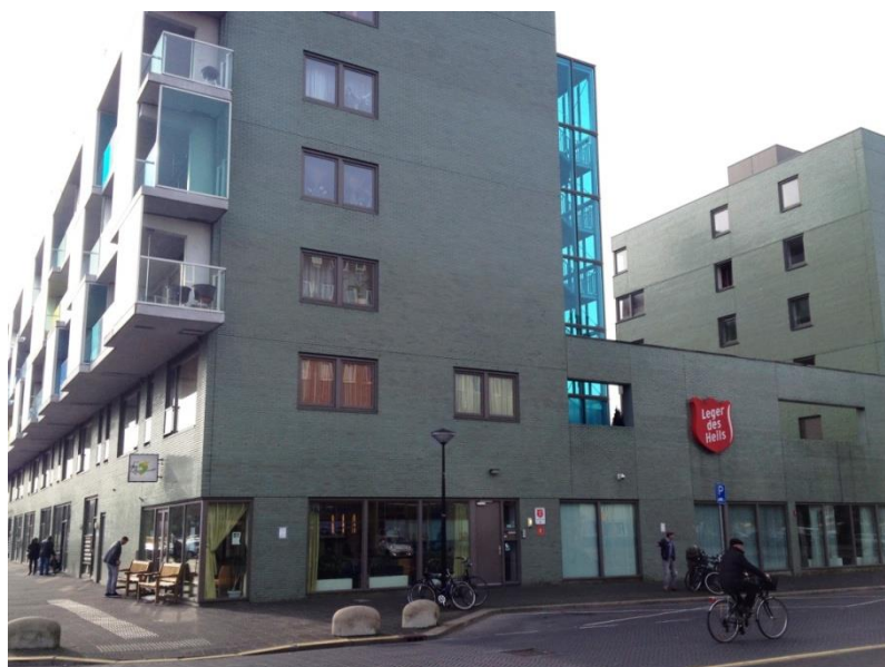
Het eerste blok vanuit de Groesbeekdreef met in de plint gemengde voorzieningen
