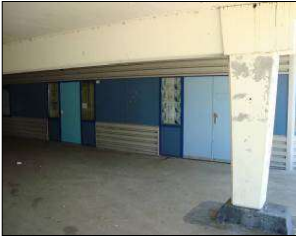
Afbeeldingen: Binnenkant parkeergarage
