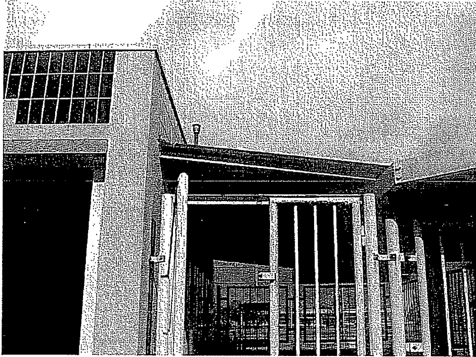
Foto 3: Asbestvrije golplaten afdak (Abm-003)
