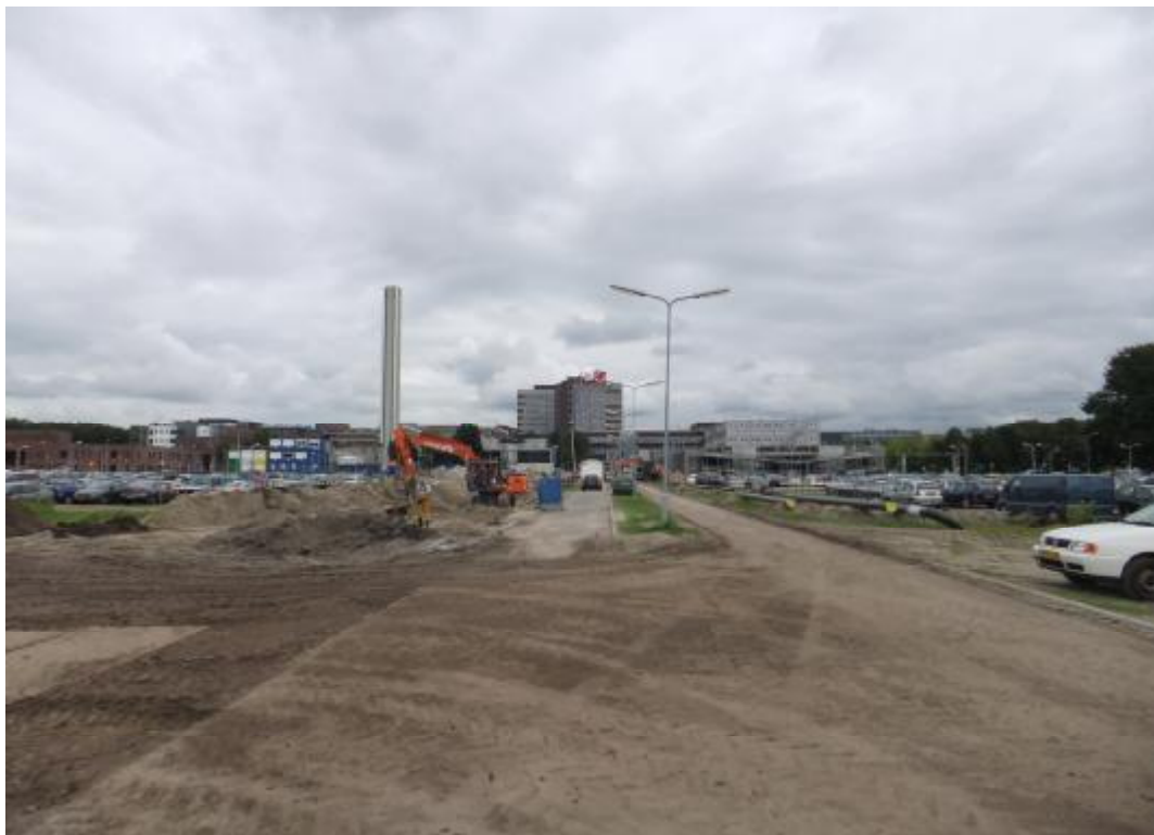
Figuur 6: Het AMC gezien vanaf de westzijde. De extra aansluiting op de Tafelbergweg op de voorgrond wordt volgens de planning in 2017 opengesteld voor verkeer. De aansluiting is onderdeel van het bestemmingsplan.
